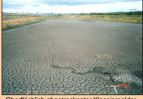
Oberflächlich abgetrockneter Klärierpolder
